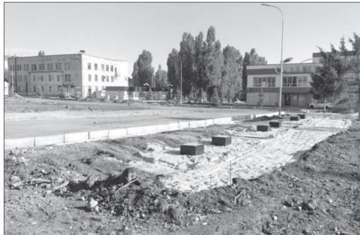
Строительные работы здесь продлятся до конца лета. На сегодняшний день выполнен демонтаж старого асфальтового покрытия, проведена разработка и вывоз грунта, демонтированы бордюры. На месте бывшей Доски почета обустроены ростверы для установки комплекса
